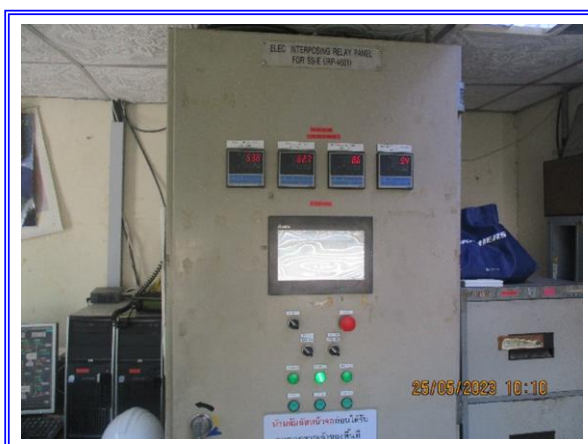
รูปที่ 3-31 ระบบ DCS ที่ Control Room ควบคุมการสูบน้ำถ่ายบริเวณท่าเรือ
