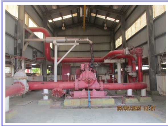
รูปที่ 3-41 ระบบปั้มน้ำดับเพลิง (Fire Pump System)
