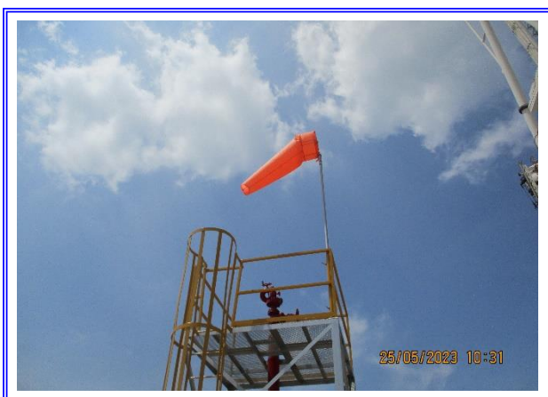
รูปที่ 3-38 Wind Sock เพื่อตรวจสอบทิศทางลม
