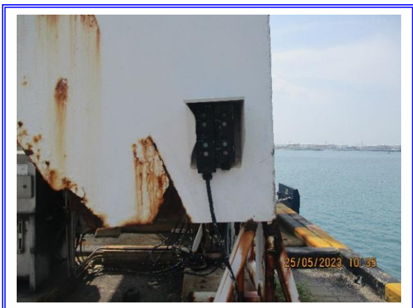
รูปที่ 3-32 Ammonia Detector บริเวณ Loading Arm
