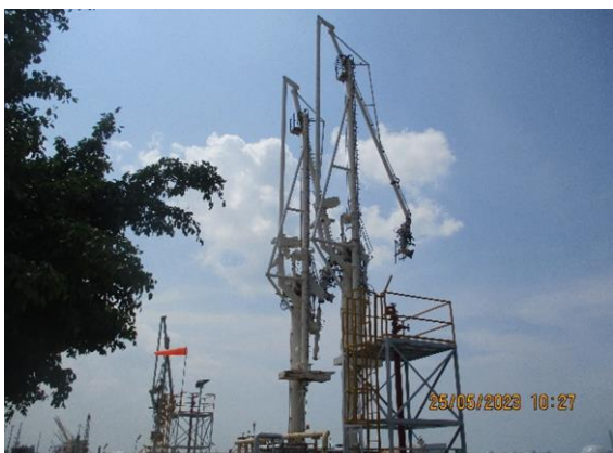
รูปที่ 3-1 Loading Arm แบบ Flexible Hose ทำงานด้วยระบบ Hydraulic
